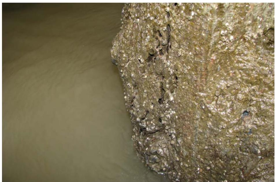
Bild 2: Diese Holzoberfläche zeigt verschiedene Schäden, hier überwiegend Seepocken und einige Öffnungen im Holz. Diese Öffnungen sind aber nicht von der Bohrmuschel, sondern von der Wasserbohrassel. Die Bohrmuschel vermeidet Beschädigungen der Holzoberfläche.
