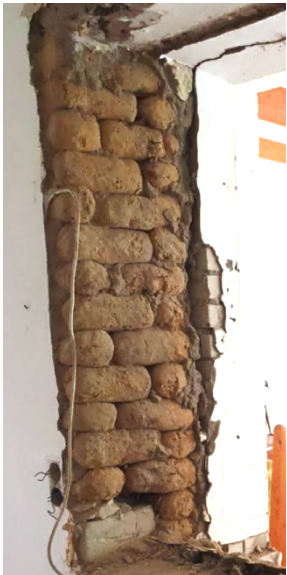
Umbau des Wiesenhauses: Nach 100 Jahren erblicken diese Lehmbröte wieder Tageslicht.
